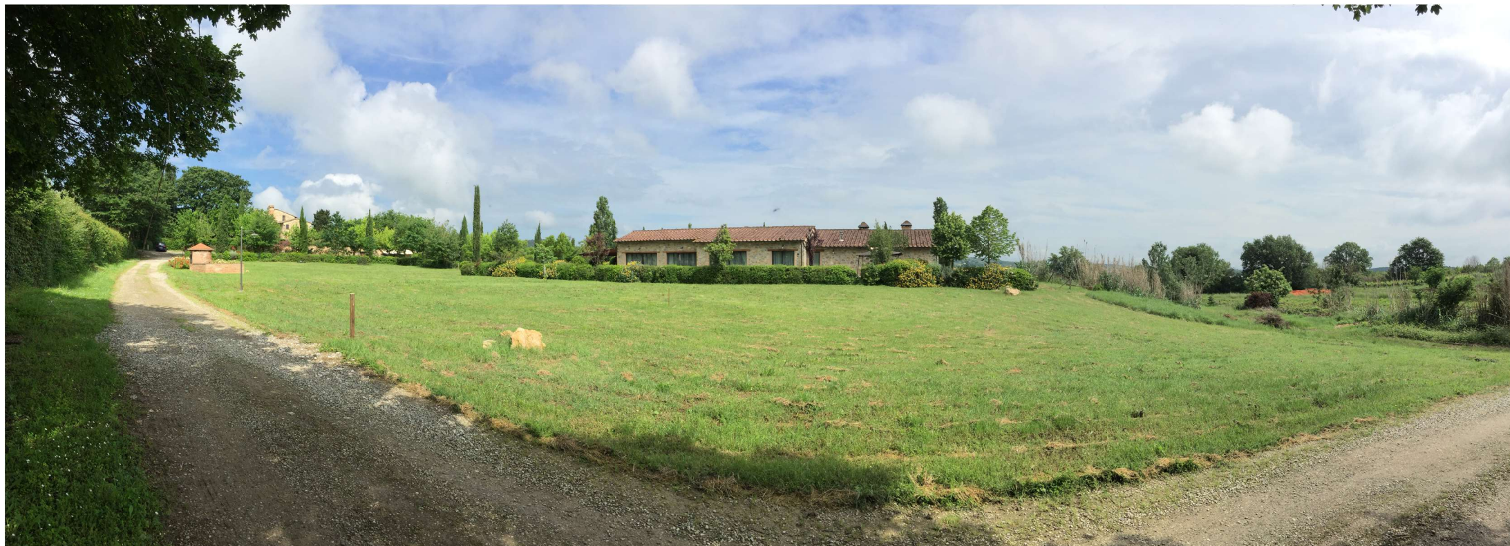
RISTORANTE (001) ZONA NUOVO EDIFICIO (006)
