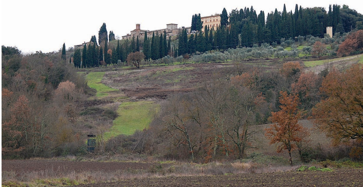
Figura 4: Vista dell'aggregato dalla SP 541
