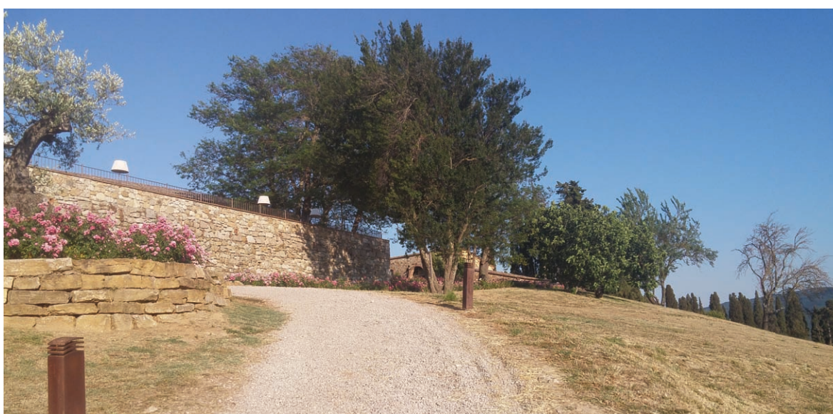
Figura 7: Muri di sostegno e scarpate sul lato sud-ovest
